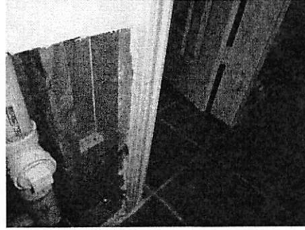
Laundry tall door frame
