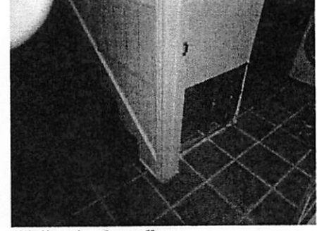
Hall stairs drywall
