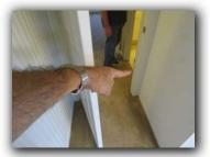
THE GARAGE ENTRY DOOR IS NOT SELF CLOSING AS REQUIRED FOR FIRE SAFETY FOR ATTACHED GARAGE ENTRY DOORS.
