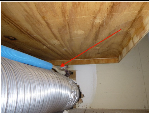
*Complete electrical conduit
