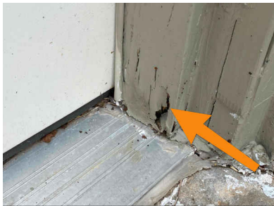
Side garage door
