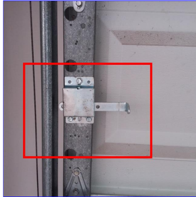
G. Item 2(Picture) Right door
