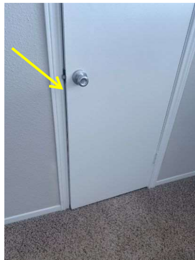
Door jamb in frame -closet door upper level
