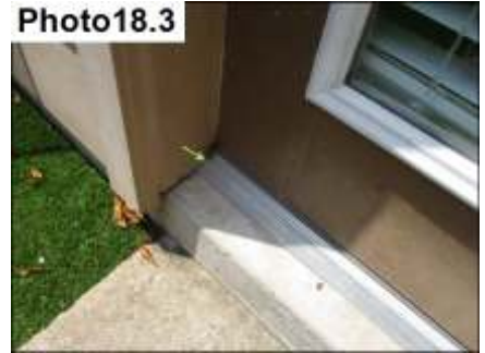
Door Miter Sealants/ Seal
