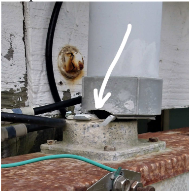
Broken conduit.
