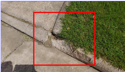
L. Item 3 (Picture) Curb
