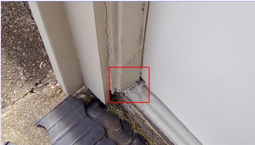
G. Item 5(Picture) left jamb
