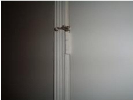
Garage barrier door
