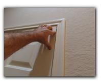
THE GARAGE ENTRY DOOR IS NOT SELF CLOSING AS REQUIRED FOR FIRE SAFETY FOR ATTACHED GARAGE ENTRY DOORS.\*\*(Deficiency)\*\*
