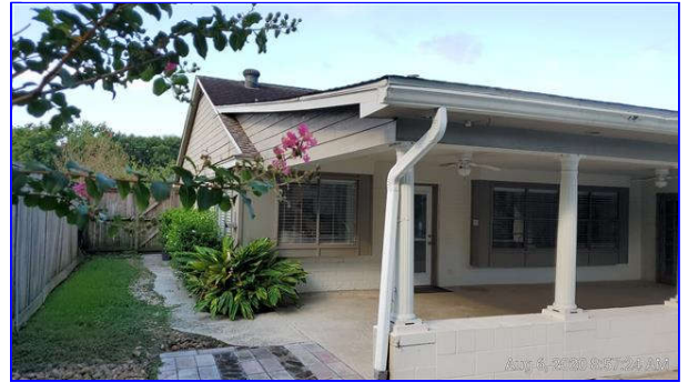
L. Item 4(Picture) Rear right elevation
