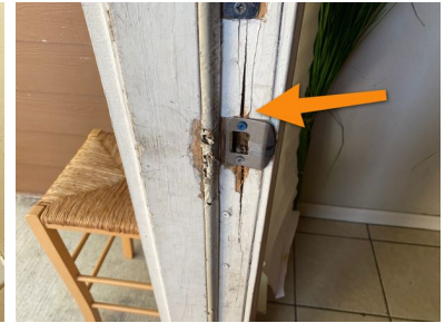
Front door unit A
