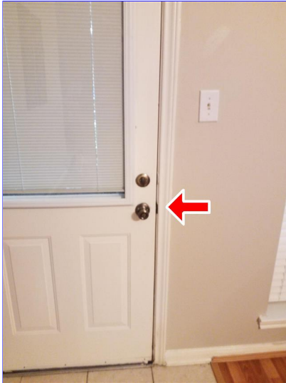
G. Item 3 (Picture) Patio door
