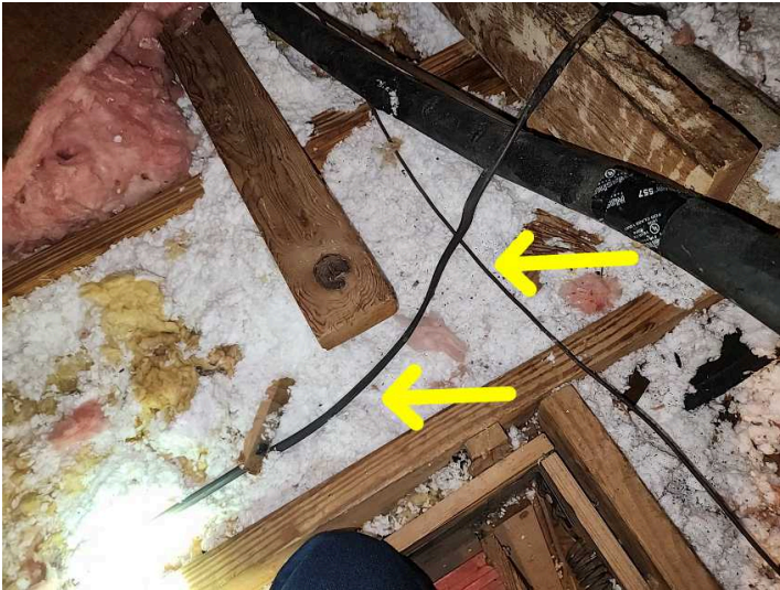
Loose wiring
