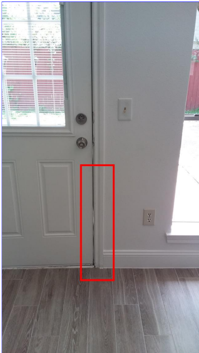
G. Item 7(Picture) patio
