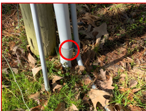
Damaged conduit
